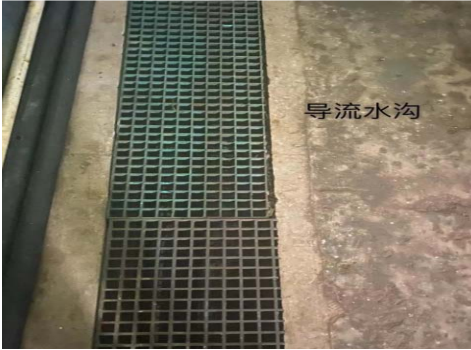
图 3.2-3 生产车间废水导流沟槽
