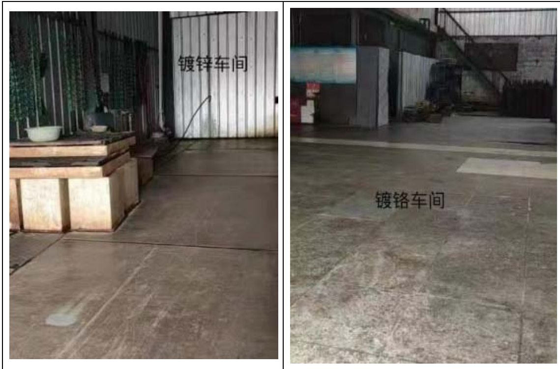
图 3.2-1 生产车间防渗地面
